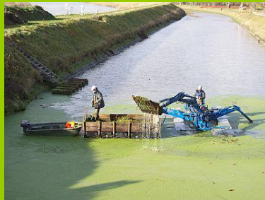
Arrachage mécanique de la jussie
