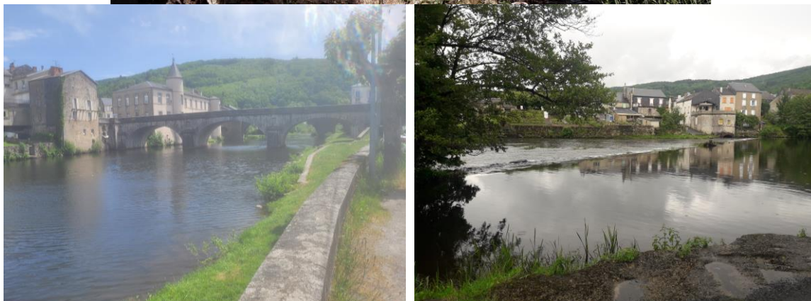
Illustration 6 : Ouvrages en travers de l'Agout sur la commune de Brassac
