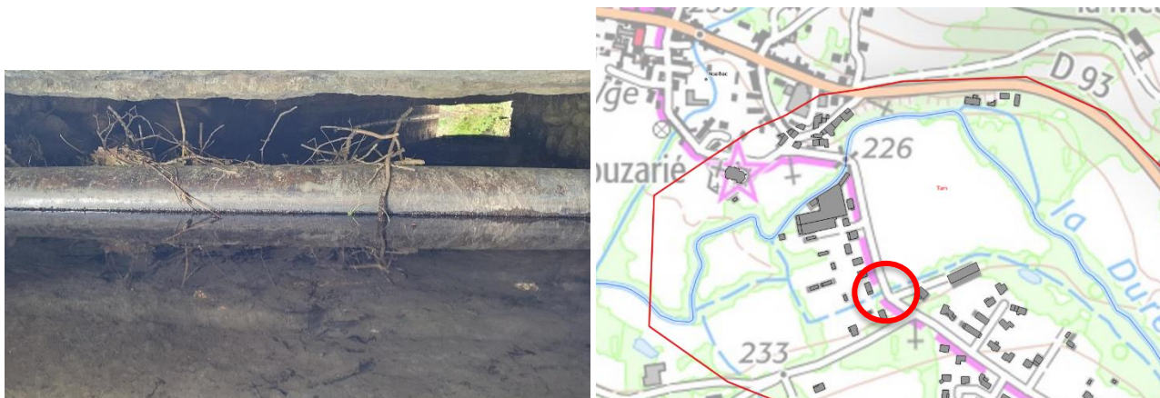
Illustration 3 : Conduite d'évacuation sous le pont
