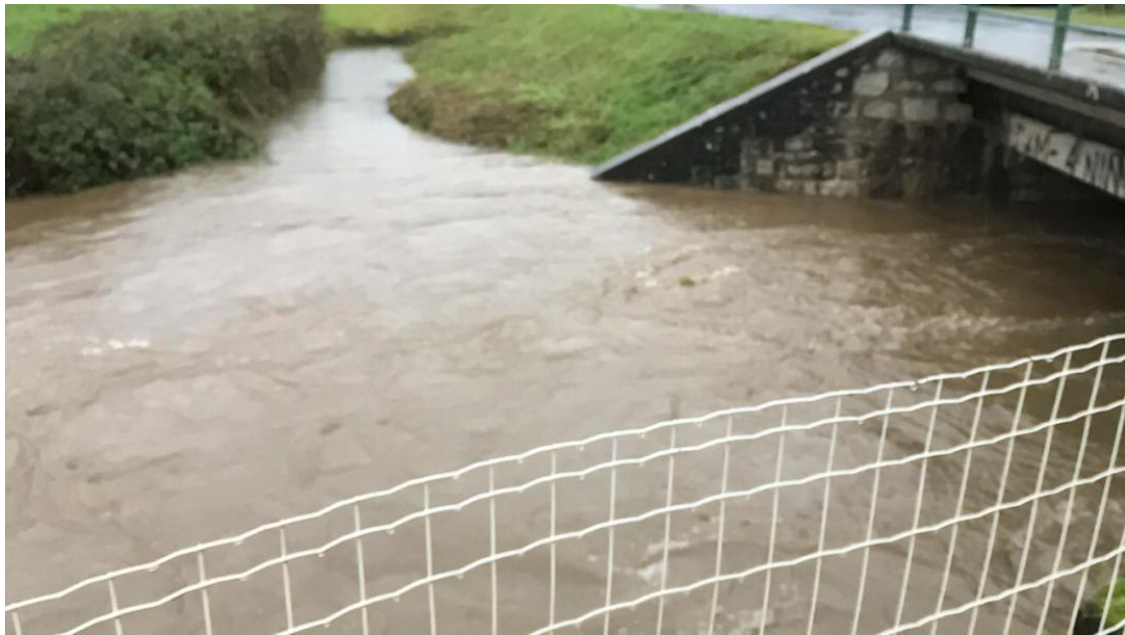
Illustration 9 : Pont sur la Durenque durant la crue de 2020
