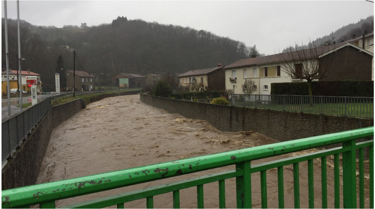
Figure 54 : Aperçu des ouvrages de protection bétonnés de Labastide – Crue de février 2017
