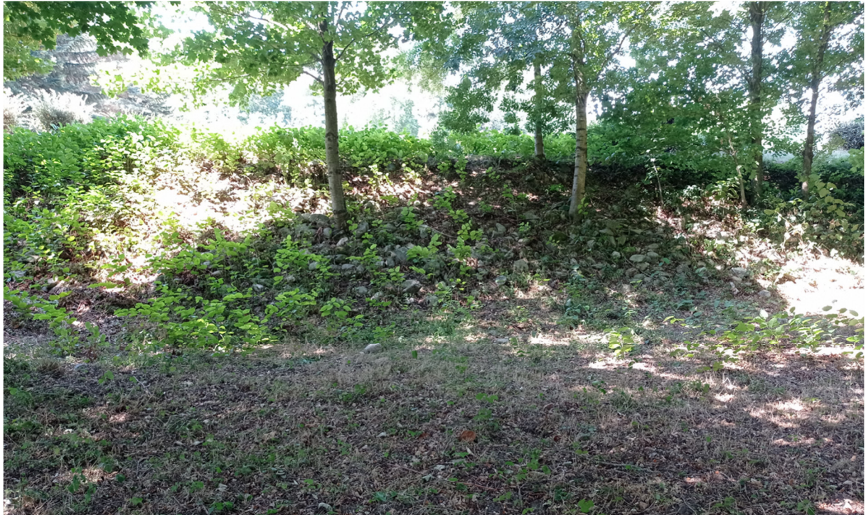
Figure 56 : Vue latérale de l'ouvrage de protection hydraulique de Saint-Amans-Soult
