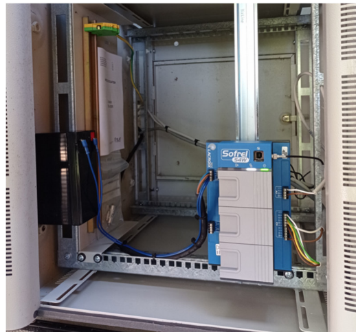
Figure 31 : Equipements de surveillance en place à Saint-Amans-Soult
