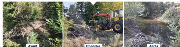
Photos : avant et après enlèvement d'embâcles, commune de Lempaut.
