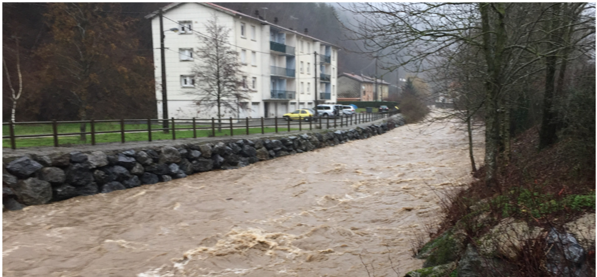
Figure 55 : Aperçu des ouvrages de protection de type enrochement de Labastide – Crue de février 2017
