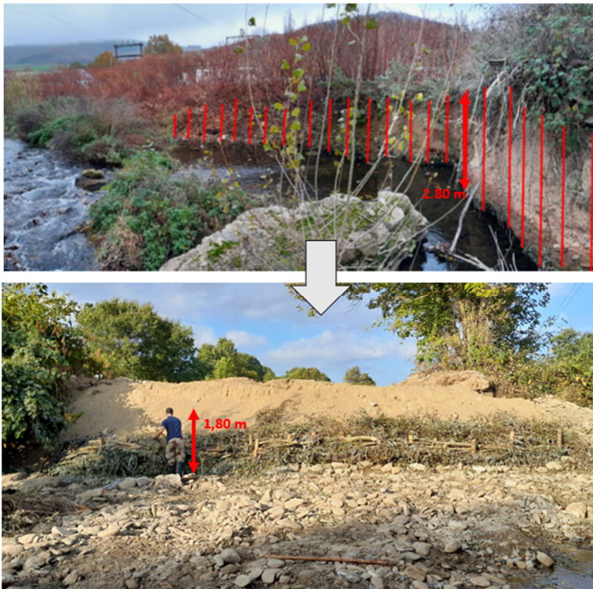
Figure 52 : Etat du site de Sauveterre avant et après travaux
