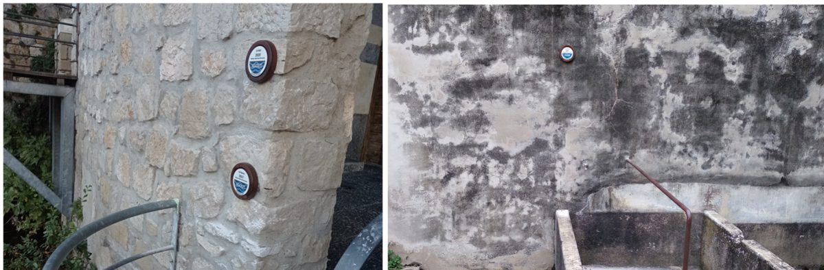
Figure 25 : Repères de crues du quai Miredames à Castres (gauche) et du lavoir à Caucalières (à droite)
