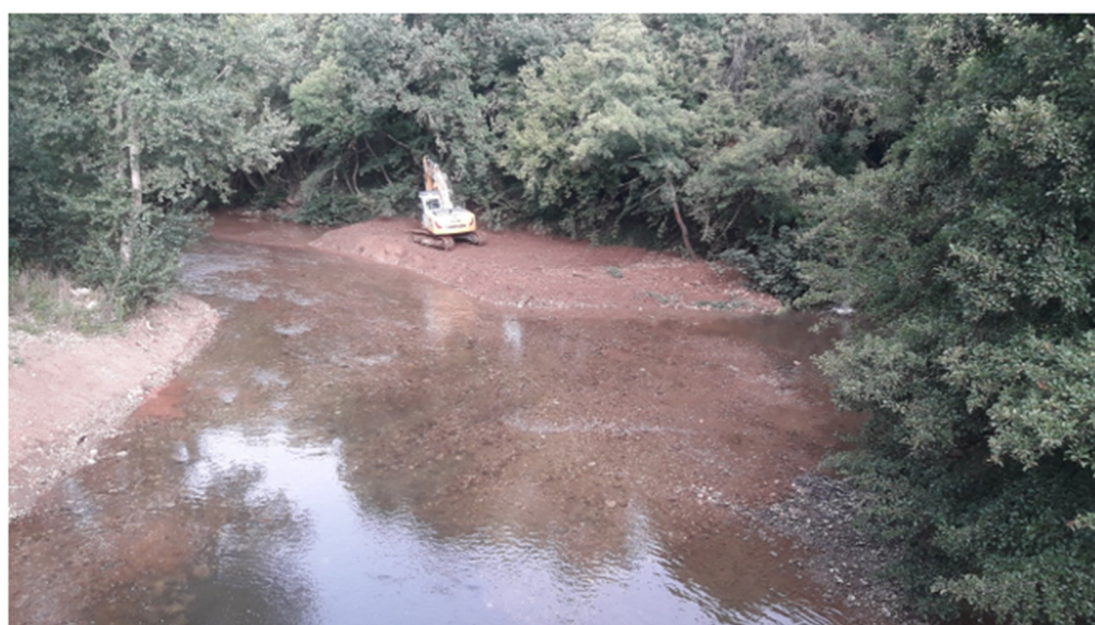
Figure 53 : Etat du site de Montdragon avant, pendant et après travaux
